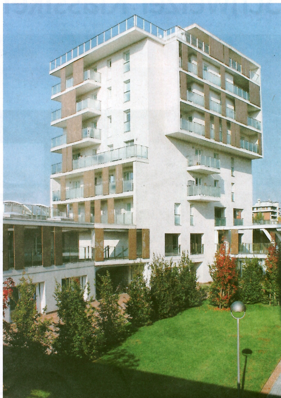
Blick auf einen der vier neugeschossigen Brettsperrholz-Türme der Wohnüberbauung «Via Cenni» in Mailand (Architektur: Fabrizio Rossi Prodi, Florenz; Holzbauingenieur: Borlini & Zanini SA, Montagnola / Lugano Sud). BILD ANDREA BERNASCONI
