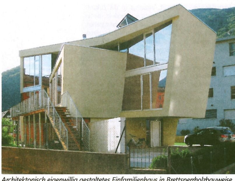
Architektonisch eigenwillig gestaltetes Einfamilienhaus in Brettsperrholzbauweise in Bellinzona (Architektur: DCA Diego Caramma Architecture, Stabio; Holzbauingenieur: Borlini & Zanini SA, Montagnola / Lugano Sud). BILD ANDREA BERNASCONI
